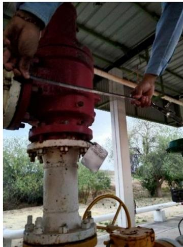
Figura 17: sondeo de válvulas.
