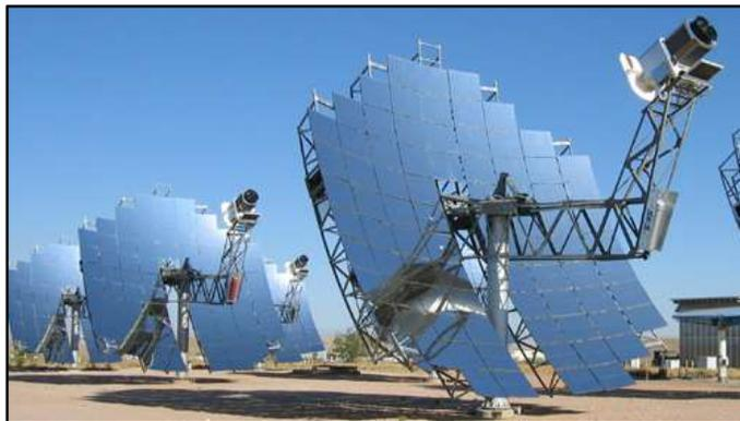
Figura 4. Sistema de disco parabólico.
