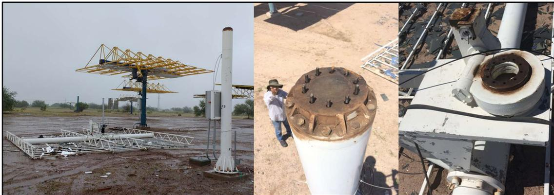
Figura 9. Daños en heliostato debido al huracán Newton.
