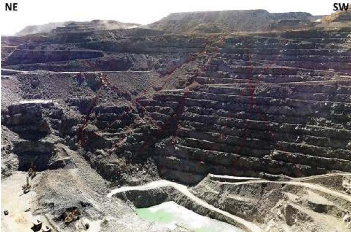
**Figura 91.** Estructuras mayores en el tajo San Francisco. La estabilidad del talud S es afectada directamente por la intersección de los planos de estructuras mayores, foliación y actitud del talud.
