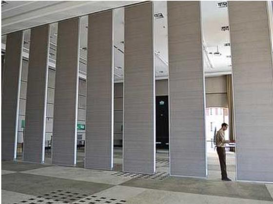
Imagen 2.2 Muros desmontables. Fuente: AluTécnic
